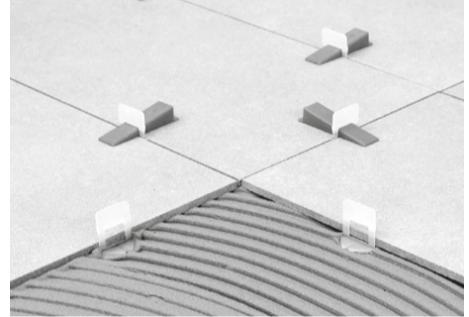
**1. KORAK** Nakon nanošenja ljepljivog ljepljiva na podlogu postaviti baze za nивелирање испод пластице, тако да се налазе уздиш све четири стране пластице. Nakon тога поставити сусједну пластицу.
