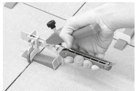
**2. KORAK** Umetnuti kajlu u otvor na bazi za nivелiranje, te klijevima za nivелiranje pločica stegnuti dok se gornji rubovi susjednih pločica u potpunosti ne izravnaju.
