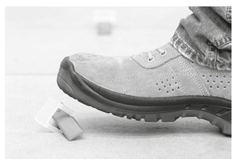
**3. KORAK** Nakon što se ljepilo u potpunosti stvrdne nogom ili gumenim čekićem ukloniti gornji dio baze za niveliranje.
