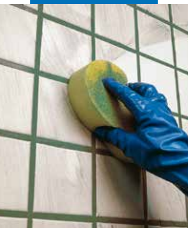
Čiščenje in zaključna obdelava fug s celulozno gobo (Mapei)
