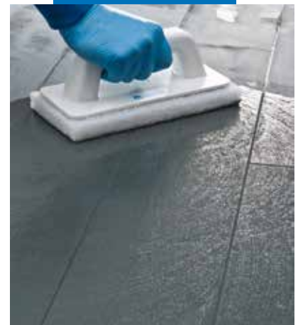
Čiščenje fugirne mase s čistilnim filcem Scotch-Brite (ko je izdelek že delno otrdel)
