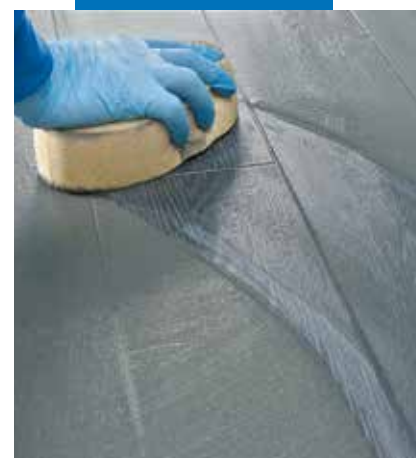
Čiščenje in zaključna obdelava fug s celulozno gobo (Mapei)
