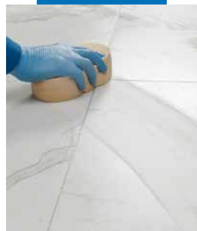
Čiščenje in zaključna obdelava fug s celulozno gobo (Mapei)
