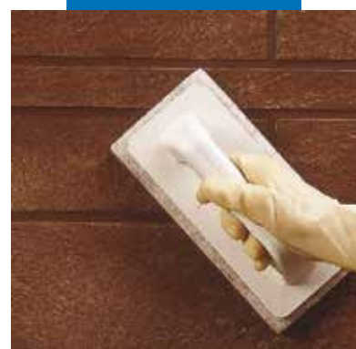
Čiščenje fug s čistilnim filcem Scotch-Brite® (ko je izdelek že delno otrdel)
