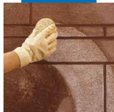
Čiščenje in zaključna obdelava fug s celulozno gobo (Mapei)
