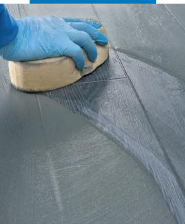
Endreinigung des Fugenmörtels mit einem Schwamm
